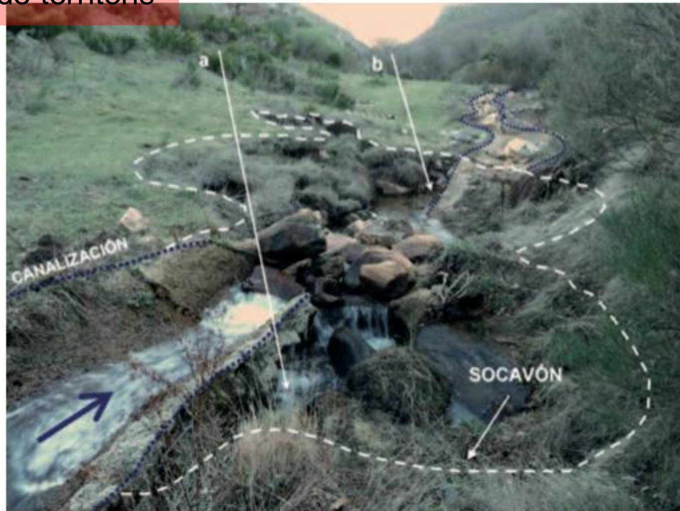
Fig. 2.- Fractura de la canalización sobre el socavón de mayor cota en el arroyo de Alcedo. En la fotografía se observan dos sumideros activos (a y b).
